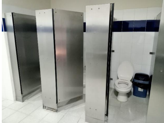
Figura 2 - Cabinas de los baños públicos del ITM.
