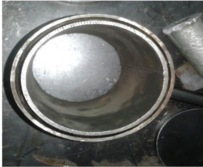
Ilustración 15. Construcción de la cámara del plenum.
