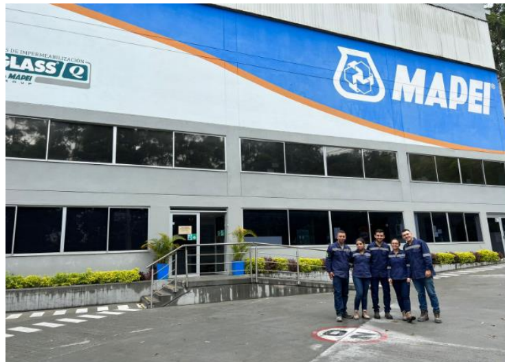
Figura 2. Planta MAPEI de la Estrella, Antioquia Fuente: Autor
