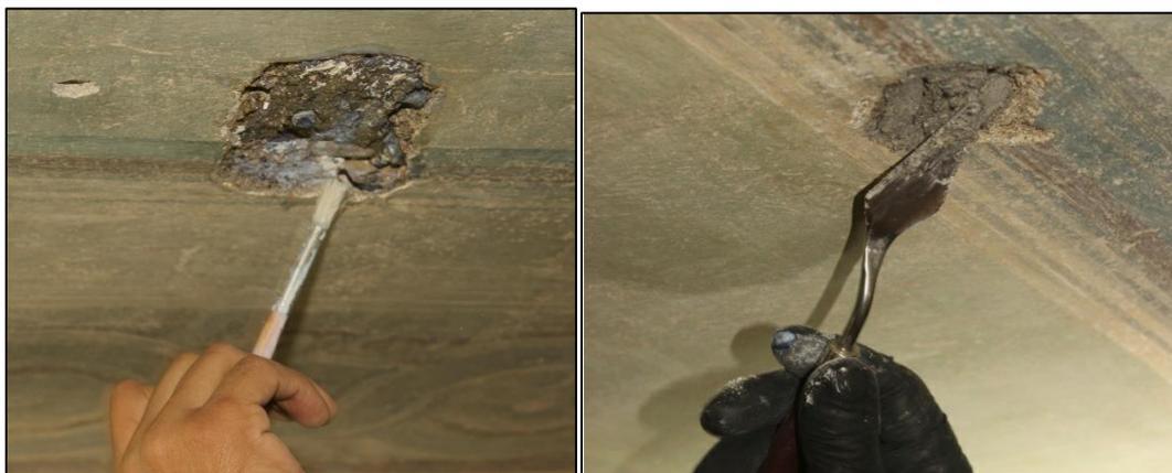
Nota: a la izquierda se observa como se coloca el puente adherente sobre el cemento antiguo y a la derecha como se llena el faltante con cemento nuevo. Fotografías tomadas por Óscar Correa en el recibidor del Claustro San Ignacio de Comfama.
