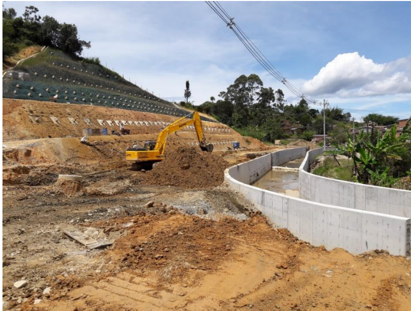
Figura 31. Obra Circunvalar Santo Domingo Antioquia Junio-2019 INGENIERIA Y CONSTRUCCIONES S.A.S.
