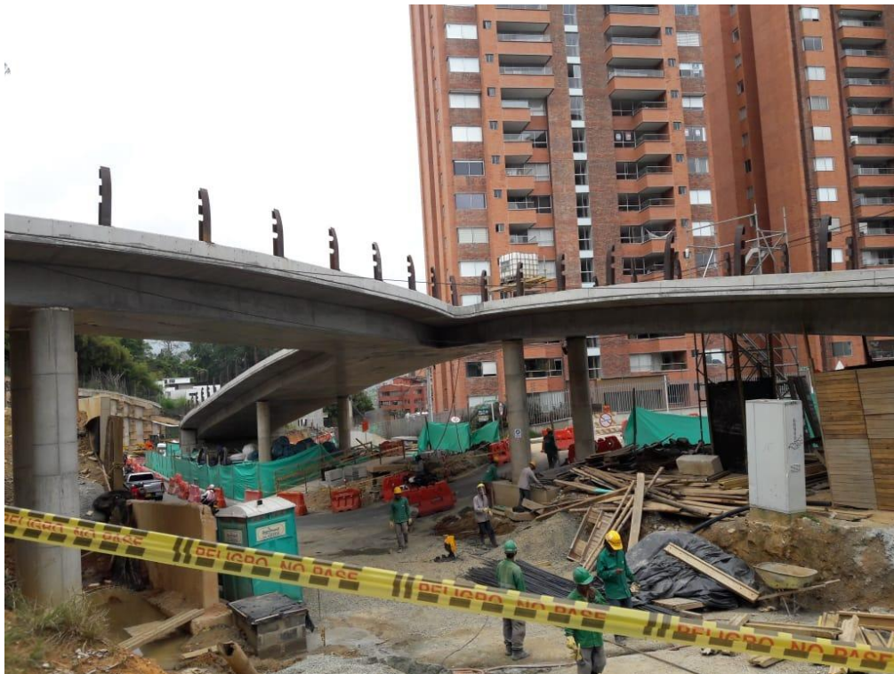
Figura 23. Obra Intercambio Vial Loma Esmeralda Envigado Marzo-2019 INGENIERIA Y CONSTRUCCIONES S.A.S
