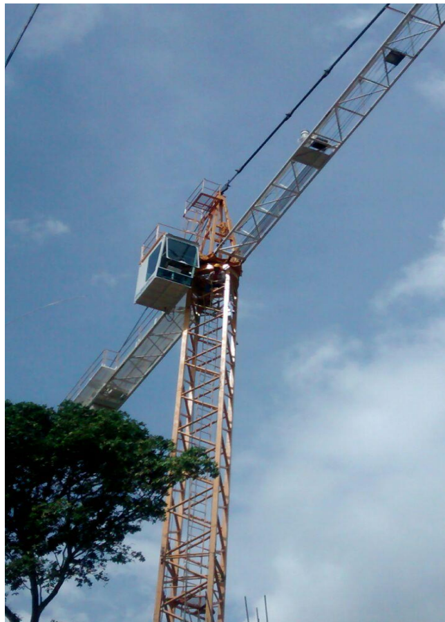
Figura 16. Torre Grúa LIEBHERR 63LC IC-TG-01 INGECON S.A.S.
