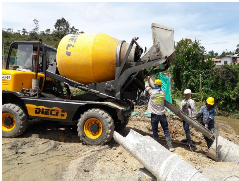
Figura 32. Vaciado Canal Obra Circunvalar Santo Domingo con Autohormigonera IC-AH-04 INGENIERIA Y CONSTRUCCIONES S.A.S.
