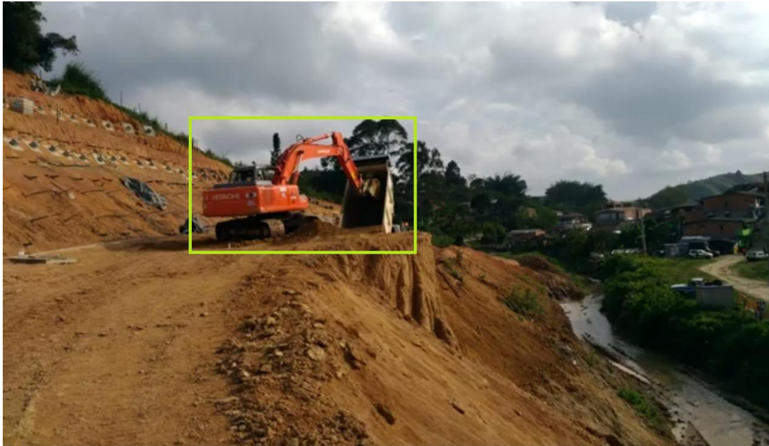
Figura 27. Excavadora IC-EC-01 y Volqueta IC-VD-21 INGENIERIA Y CONSTRUCCIONES S.A.S.
