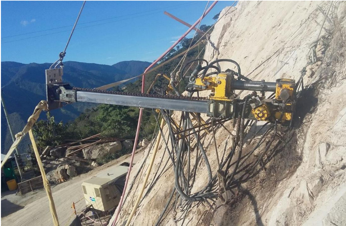
Figura 7. Perforadora Hidráulica BERETA T19 IC-PH-09 INGECON S.A.S.
