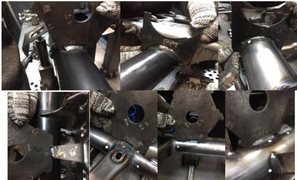
Figura 11. Verificación de cordones de soldadura.
