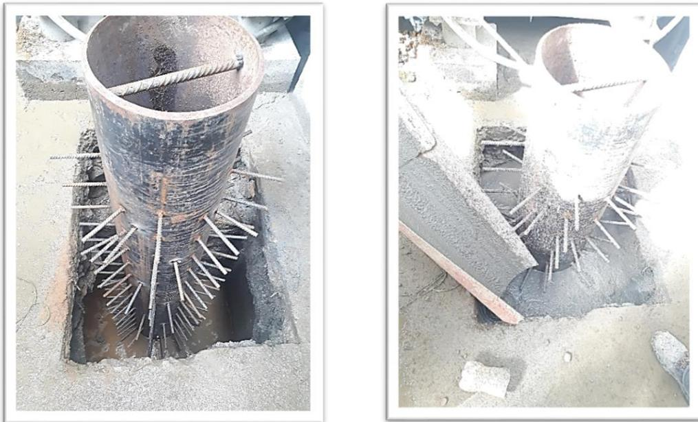
**Figura 25.** Tubo de anclaje y Vaciado (Autoría Propia)
