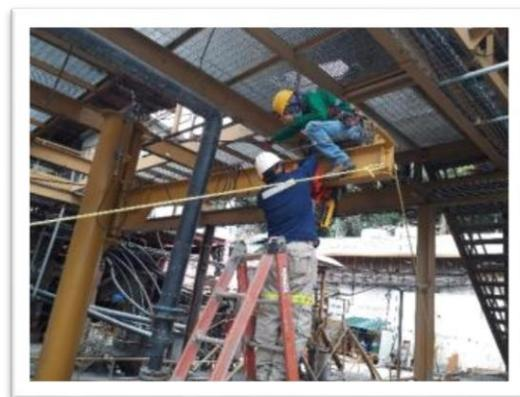
**Figura 34.** *Instalación Polipasto Y Cableado Eléctrico (Autoría Propia)*
