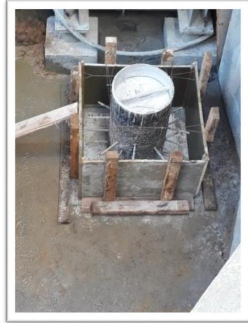
**Figura 26.** Secado de vaciado y Encofrado de Pedestal (Autoría Propia)
