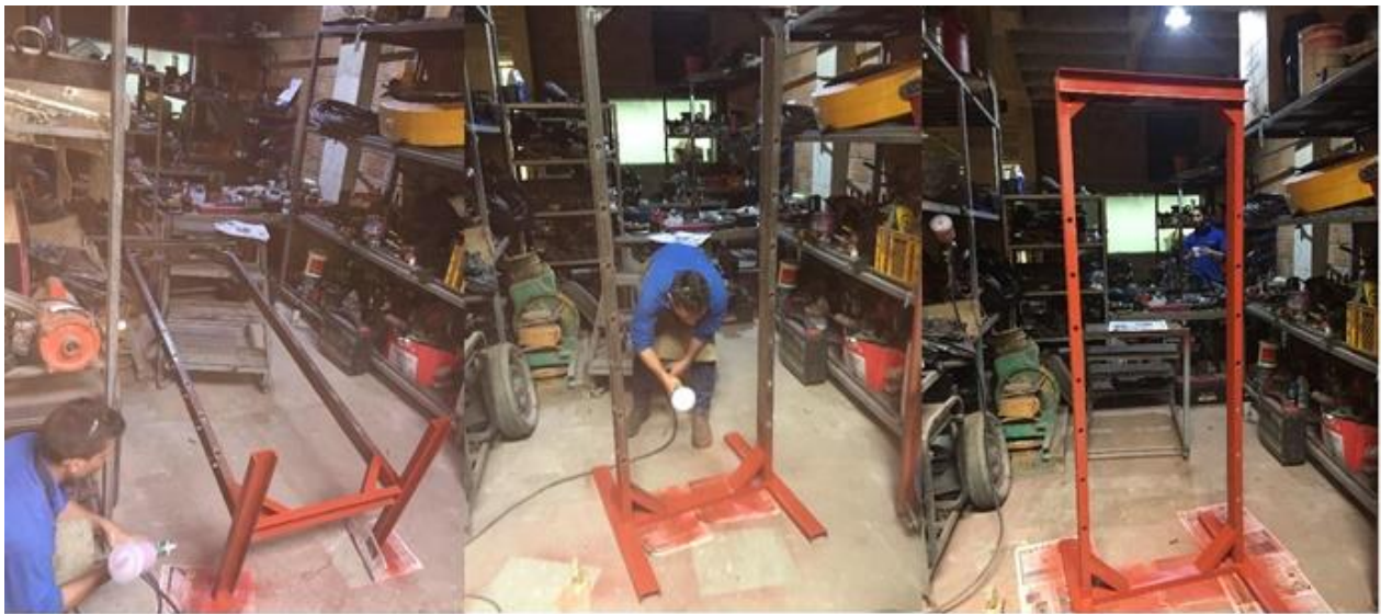
Figura 13. Aplicación de anticorrosivo.
