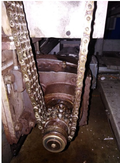
Ilustración 41. Intervención correctiva urgente
