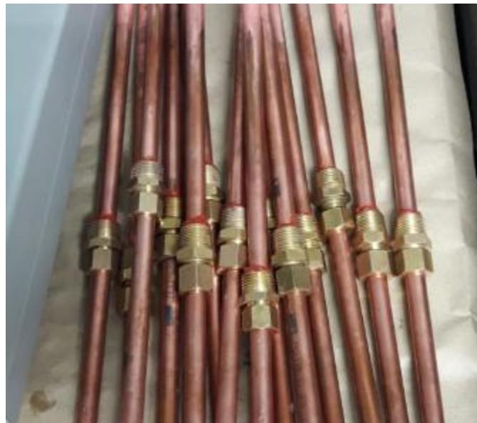
Figura 20 Tubos con racor instalado y sellado
