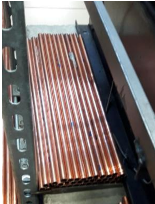
Figura 16 Nuevos tubos de cobre cortados a la medida
