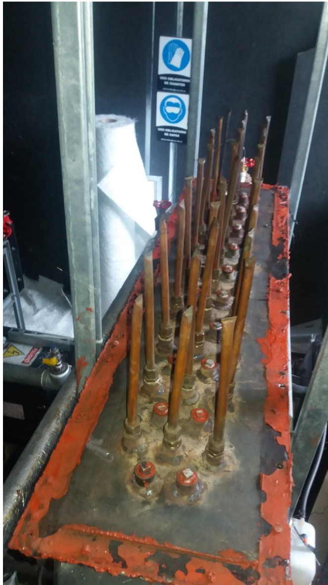
Figura 12 Vista superior de la placa del intercambiador de calor
