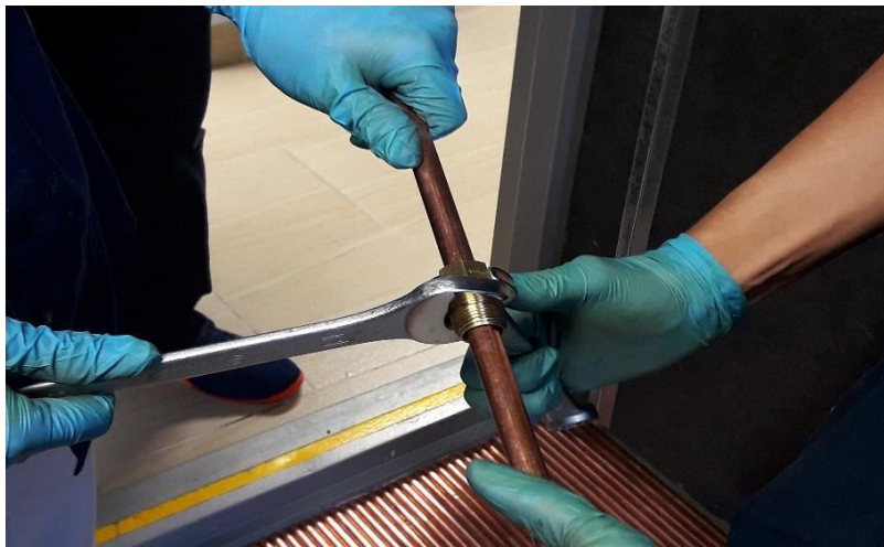
Figura 19 Fijación del racor en los tubos
