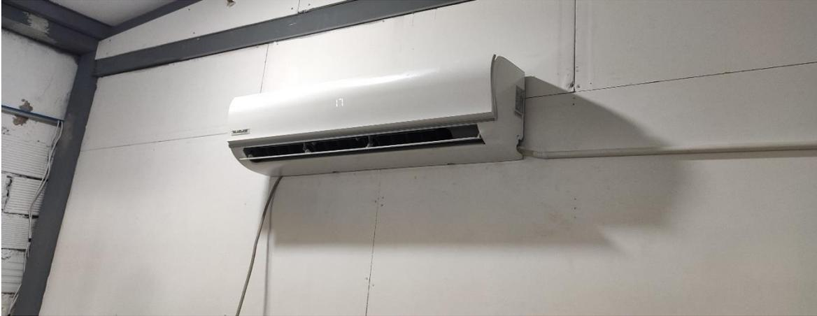
*Imagen 4 Unidad evaporadora de capacidad 12.000Btu/h en funcionamiento (FUENTE PROPIA).*
