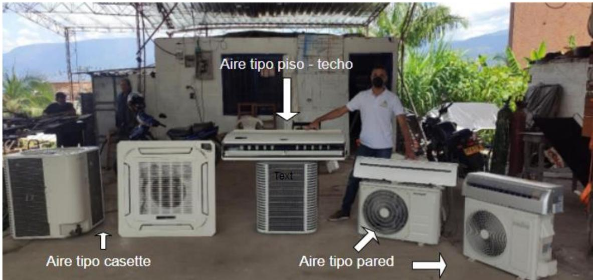
*Imagen 1 Equipos de aire acondicionado por compresión de refrigerante (FUENTE PROPIA)*
