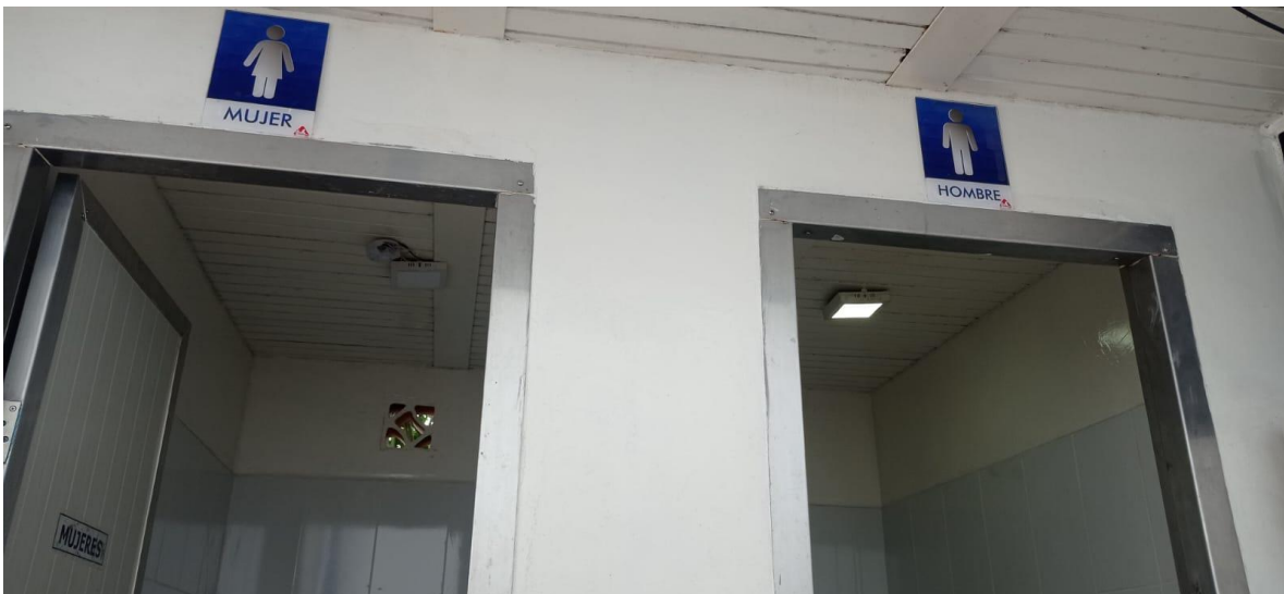
Figura 4. Luminarias LED con sensores de movimiento.
