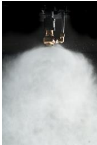
Figura 9 Sistema híbrido Vortex. (Carvajal M, 2019)
