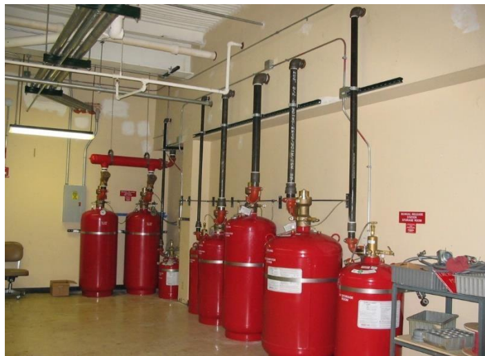
Figura 11 Sistema de agua nebulizada. (Carvajal M, 2019)
