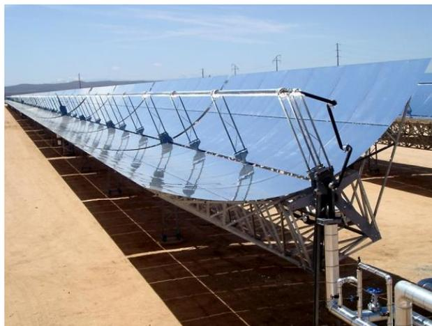
**Figura 5:** Colectores cilíndricos parabólicos.
