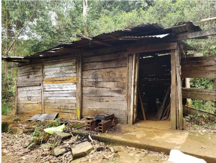
Fotografía 3-2: Vivienda en barrio La Avanzada, comuna 1, 2019
