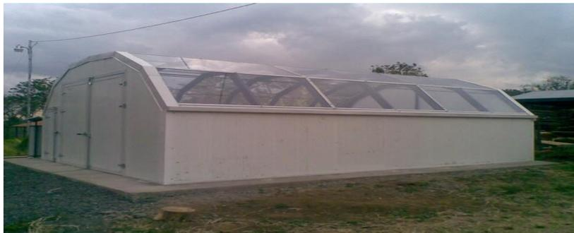
Figura 14. Ejemplo de secador solar construido de lámina de latón y vidrio.
