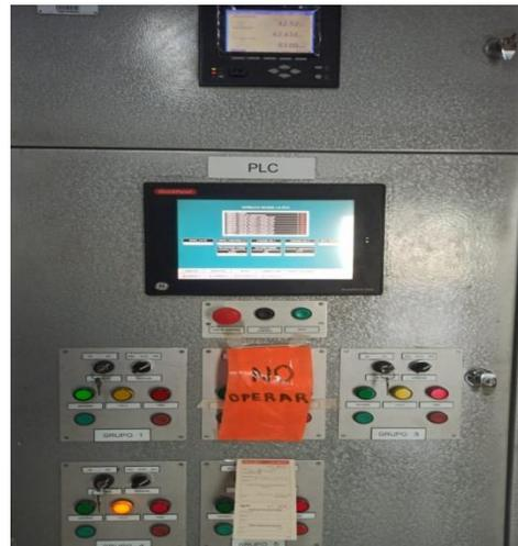
**Figura 9. Tablero de control y PLC.**
