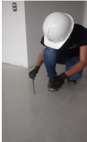
Foto tomada dentro de la obra Mostaza 9
