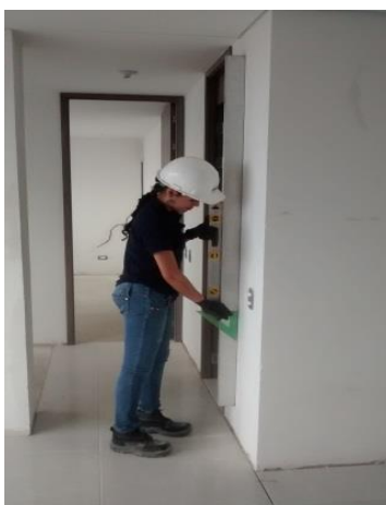
Foto tomada dentro de la obra Mostaza 2
