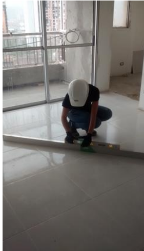
Foto tomada dentro de la obra Mostaza 4
