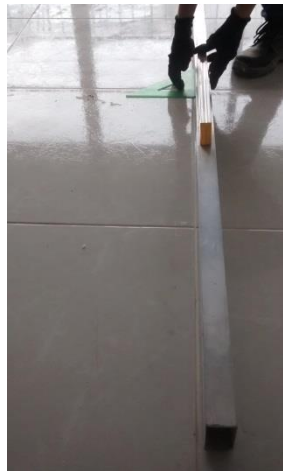
Foto tomada dentro de la obra Mostaza 8
