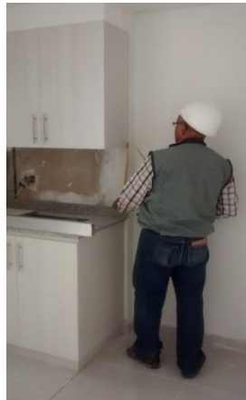
Foto tomada dentro de la obra Mostaza 3
