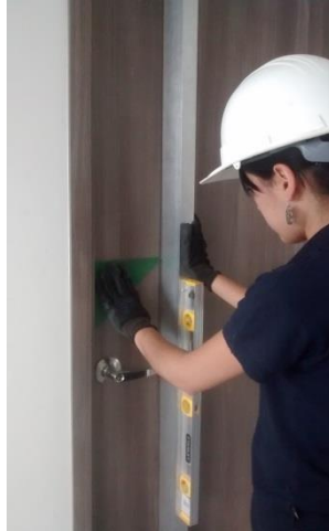
Foto tomada dentro de la obra Mostaza 6
