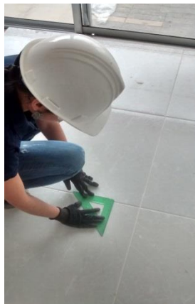
Foto tomada dentro de la obra Mostaza 1
