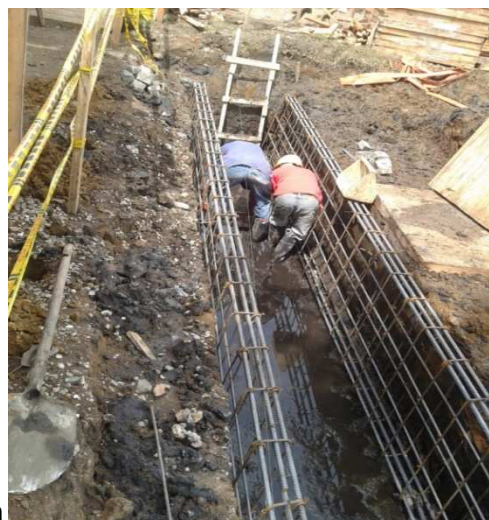
Instalación acero de refuerzo muro guía
