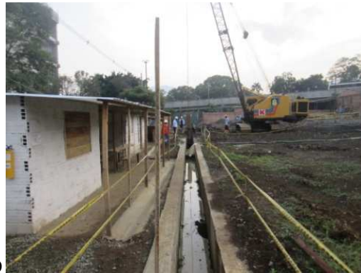
Excavación Muro colado
