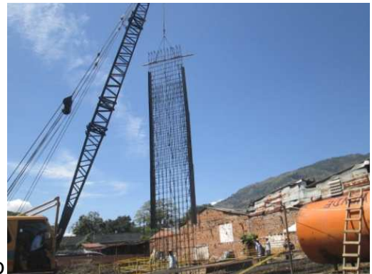
Instalación acero de refuerzo muro colado
