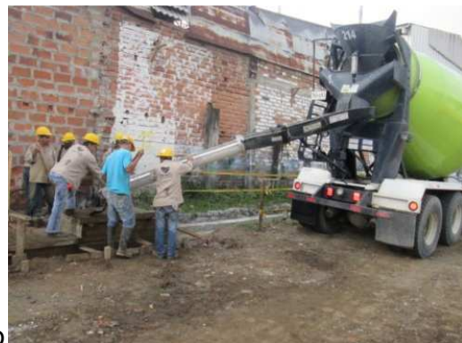
Vaciado concreto Tremie muro colado
