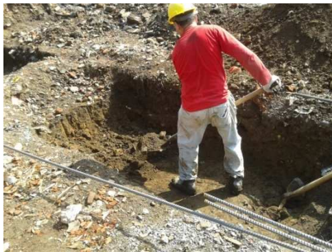
Excavación Manual muro guía
