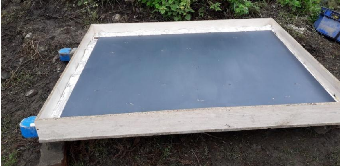
Figura 15. Ensamble del cajón con el emparrillado
