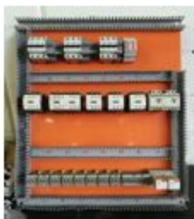
Montaje Tablero Control
