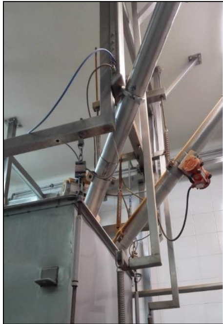
Figura N° 5: Inclinación de ductos con vibradores
