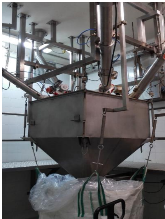
Figura N° 4: Montaje mecánico antes de la intervención
