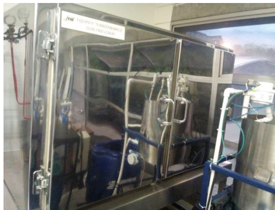
Figura 2 Evaporadores de congelación y conservación con sus respectivas puertas.
