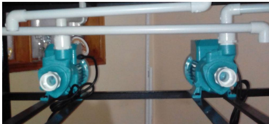
Foto 13. Motobombas adaptadas a la estructura
