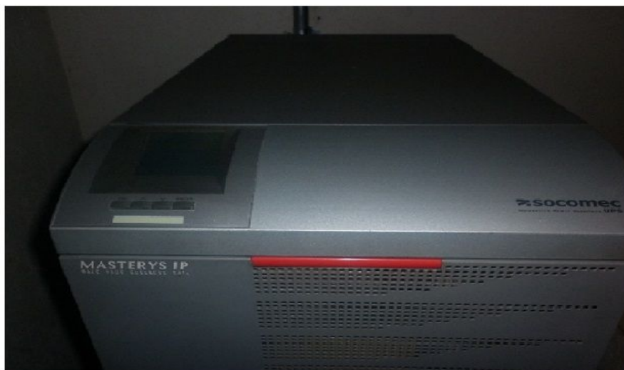
Figura 28: Sistema de Alimentación ininterrumpida (UPS). Fuente: Elaboracion propia
