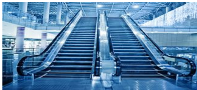
Figura 3: Escaleras mecánicas. Extraída de
