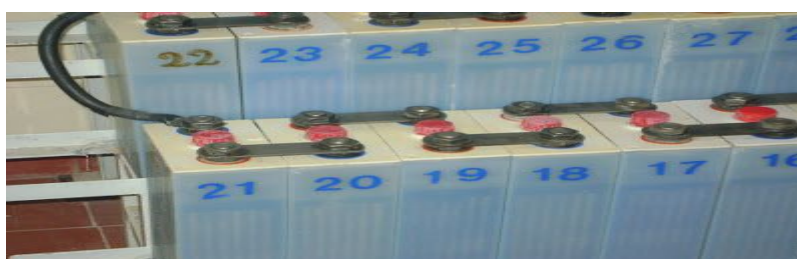
Figura 9: Conexión real en serie. Extraído de http://www.bateriasdecondensadores.com/banco-de-baterias/
