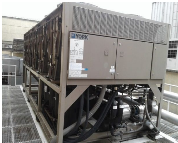
Figura 35: Compresor tipo scroll. Fuente: Elaboracion propia
