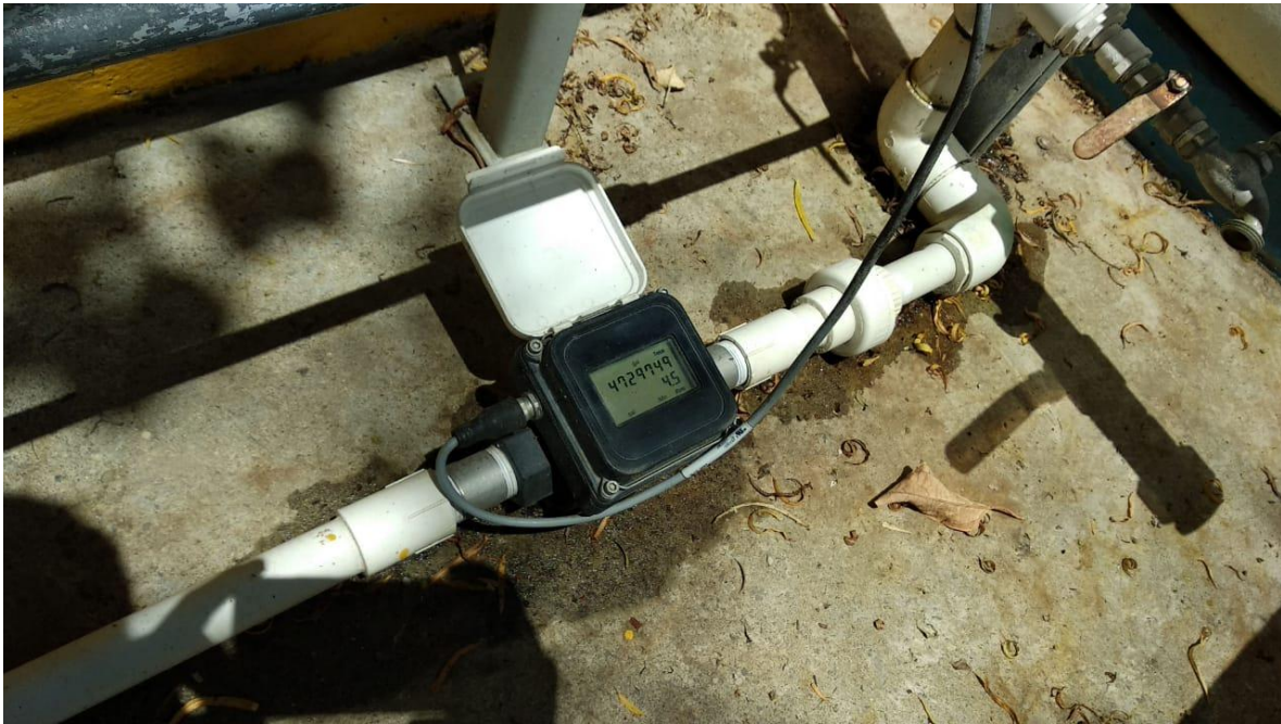
Imagen 11. Instalación de medidor de caudal y flujo (fuente: autor)
