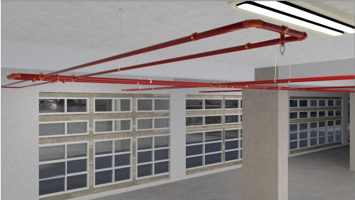
**Ilustración 46.** Renderizado sistema contra incendio en taller metal mecanico - itm Robledo.
