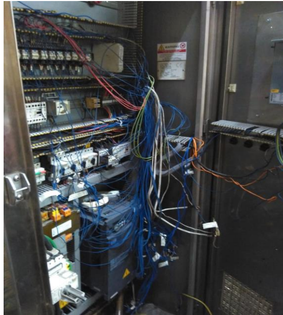
Figura 15: Avances del cableado de control (imagen capturada por el autor).
