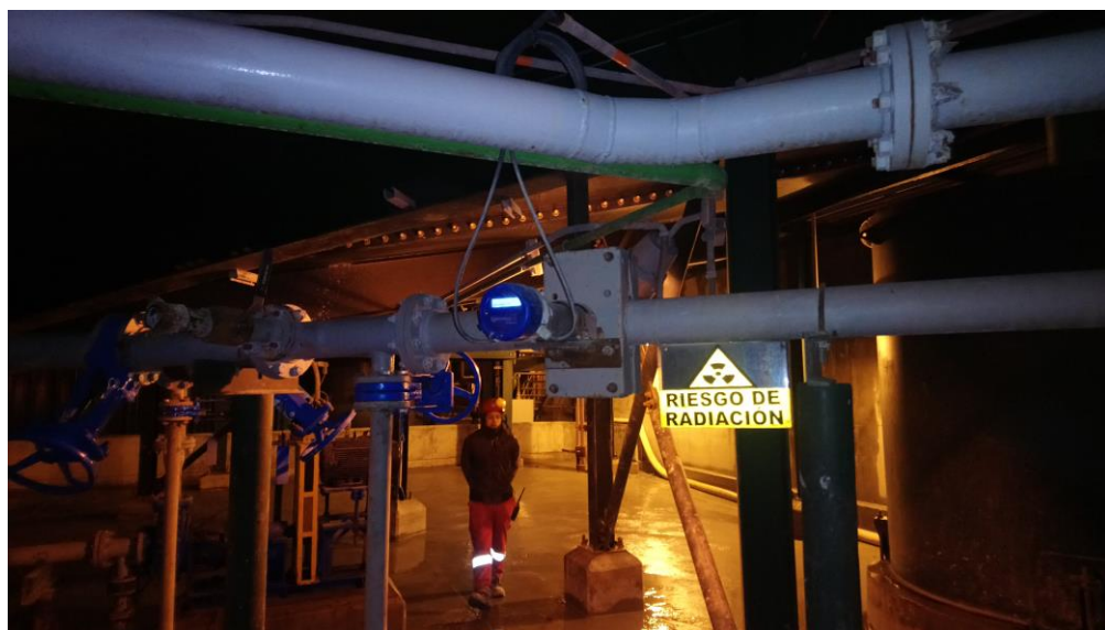
Ilustración 19. Instalación sistema de medición de densidad
