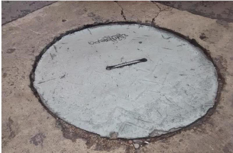
*Figura 6. Desgaste y cristalización tapa polipropileno. Fuente propia.*
