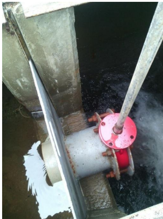
Figura 30. Eje adaptado a válvula mariposa sistema de lavado planta la milagrosa la ceja Antioquia (Propia).
