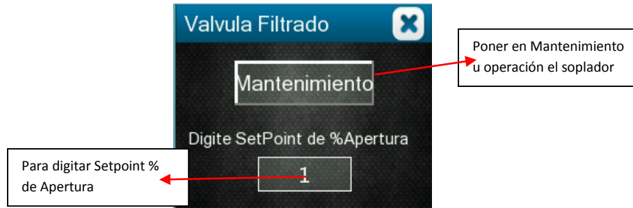
Figura 50. Accionamiento válvulas desde la pantalla. (Propia).
