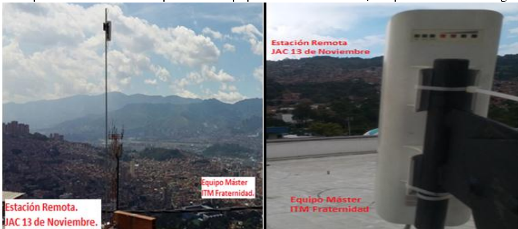
Figura 90. Disposición en terreno de los equipos del radio enlace: Estación Remota y Equipo Máster. Fuente: Autor.
