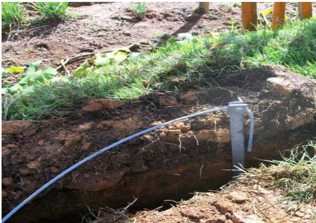
Figura 17. Instalación electrodo torre 88 (Empresas Públicas de Medellín, 2016)
