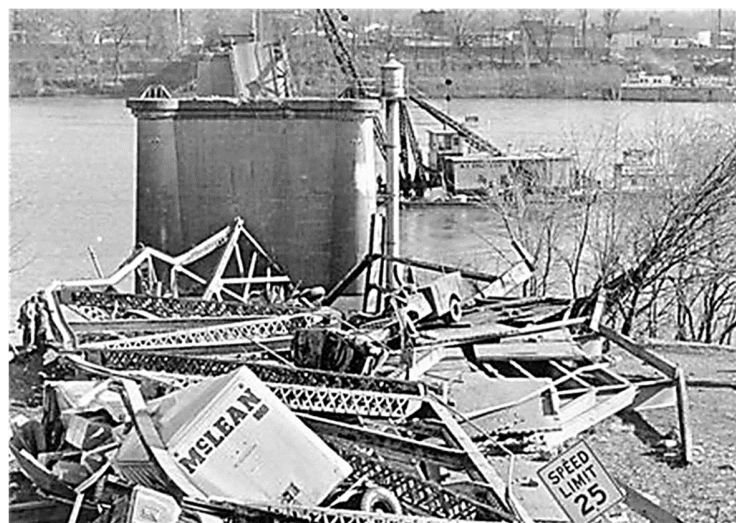
Figura 1-2: Colapso del puente Silver Bridge en diciembre de 1967. Tomado de [16].
