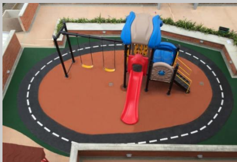
Figura 30. Vaciado de caucho reciclado, tomada de: http://craneo.co
