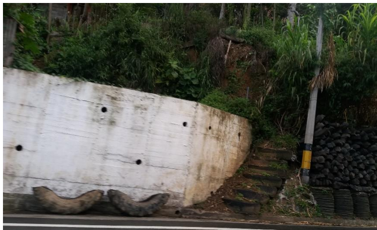
Figura 12. Carretera Santa Bárbara- La Pintada (Antioquia). Fuente: Autoría propia
