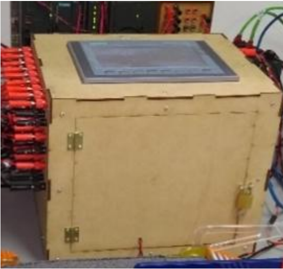
Fig 19. Caja de control
