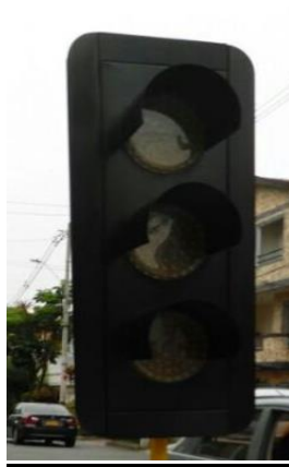
Figura 12. Parte superior del semáforo.
