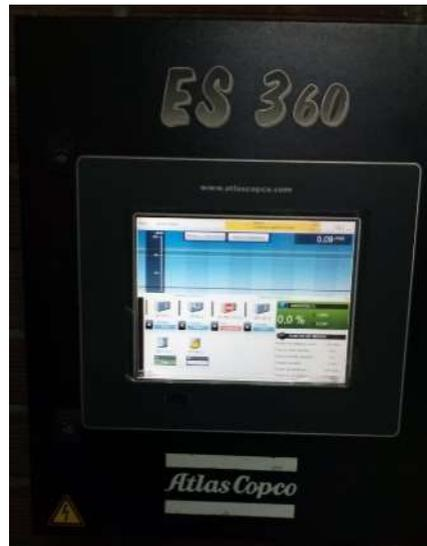
**Ilustración 36. Control maestro para estación de Generación de Aire comprimido
