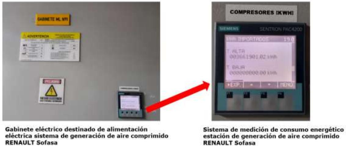
**Ilustración 20: Gabinete eléctrico y sistema de medición consumos de estación de Generación de aire comprimido de las instalaciones de RENAULT Sofasa (Ilustración de propia autoría)**
