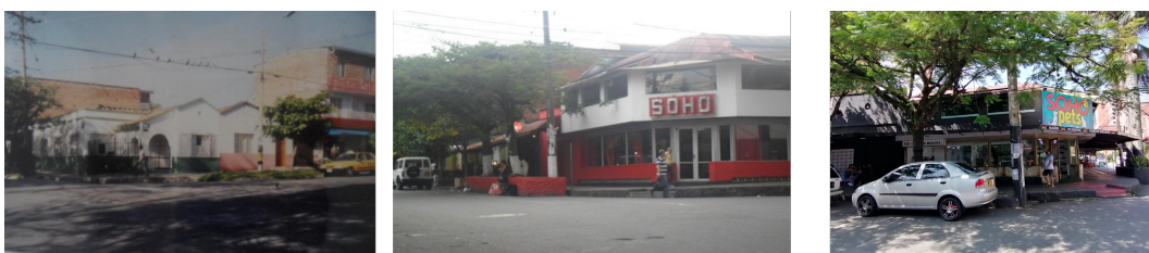
Figura 43 Calle 35 con carrera 51 en diferentes años de izquierda a derecha, 1995, 2017 y 2020. Realizado por Ana Luisa Ramírez Carmona. 2020
