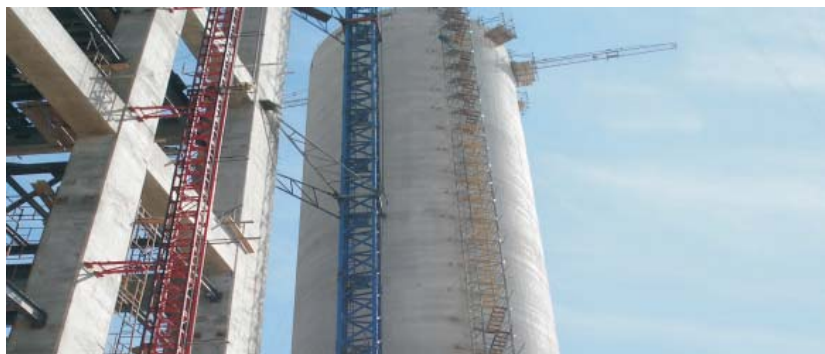
Figura. 15. Aplicación de concreto fluido.
