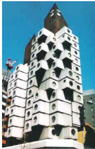
Figura. 13. Aplicación de concreto ligero.
