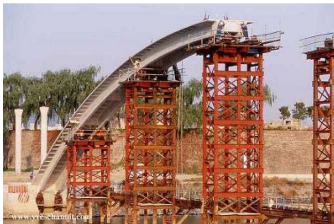
Figura. 22. Aplicación de concreto de ultra altas resistencias.
