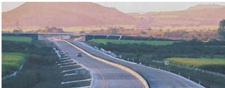
Figura. 18. Aplicación de concreto para pavimentos.
