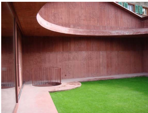
Figura. 8. Aplicación de concreto coloreado.
