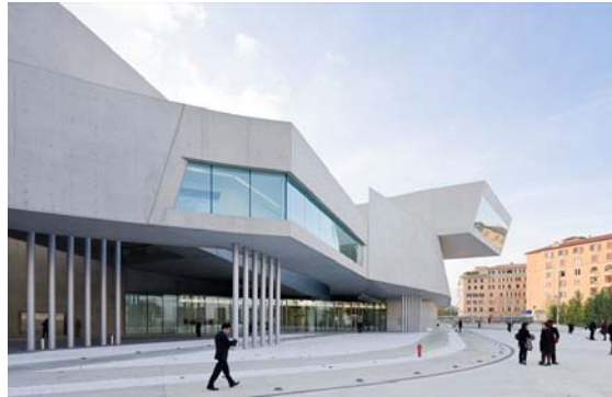
Figura. 6. Aplicación de concreto arquitectónico
