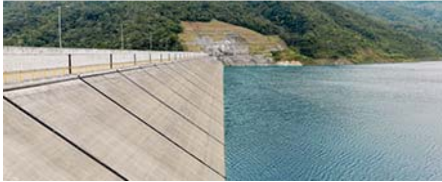
Figura. 14. Aplicación de concreto de temperatura controlada
