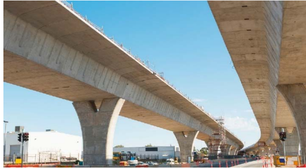
Figura. 12. Aplicación de concreto de altas resistencias
