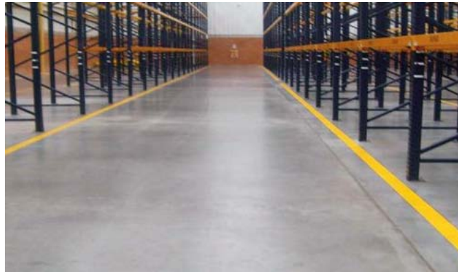
Figura. 19. Aplicación de concreto para pisos industriales
