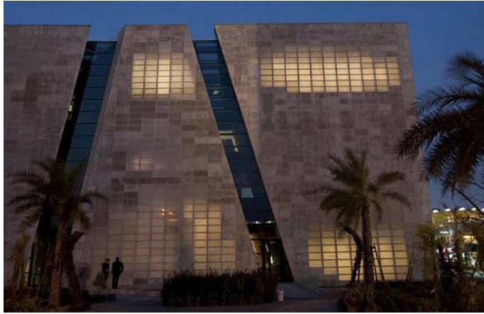
Figura. 10. Aplicación de concreto traslucido.
