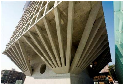
Figura. 7. Aplicación de concreto auto-compactante.
