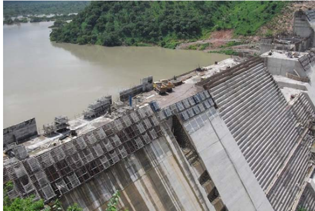
Figura. 17. Aplicación de concreto masivo.
