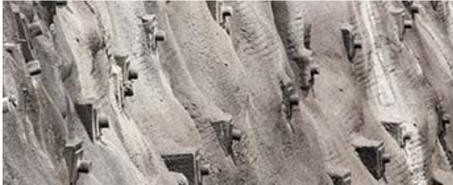
Figura. 21. Aplicación del concreto proyectado
