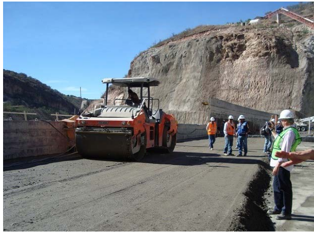
Figura. 9. Aplicación de concreto compactado con rodillo.
