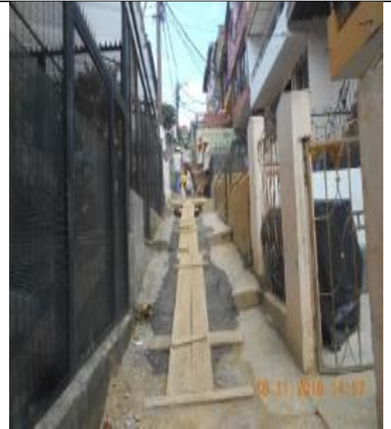
Aplicación suelo cemento y obras de protección
