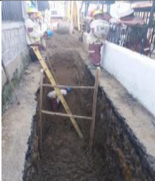
diagonal 63 entre Av. 44 y Av. 44ª
