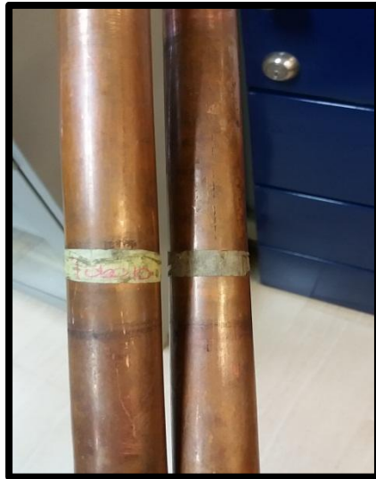
Figura 6. Tubos de calor (Elaboración propia).
