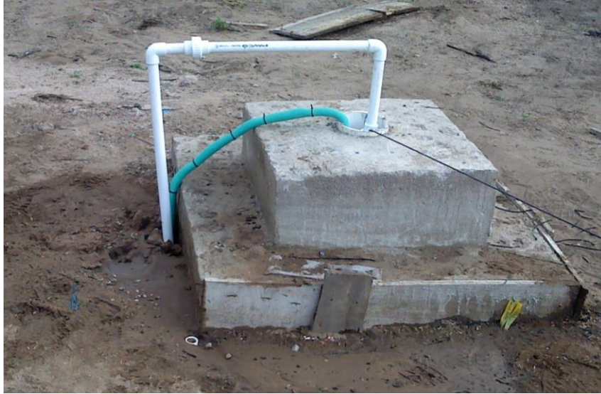
Figura 46. Pozo perforado (Durespo S.A, 2010).
