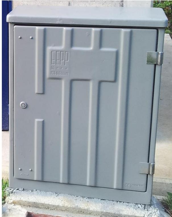
**Figura 15 Armario de Distribución Instalado.**
