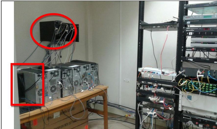
Una vez organizado el cableado y certificados los puntos para voz, se debe realizar la instalación de un SW 2900 cisco en el rack para conectar el servidor asignado por el docente Pedro Guerrero.
