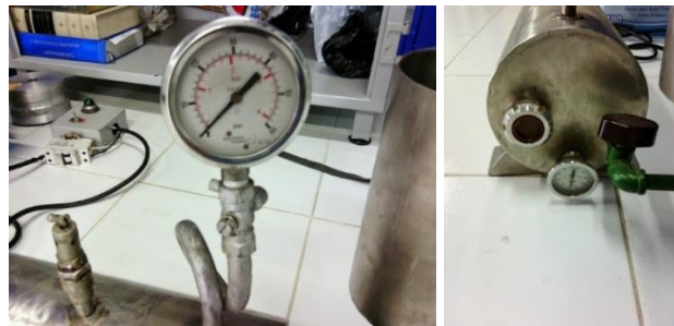
Figura 17. Mini caldera Pascual Bravo. Fuente: Elaboración Propia
