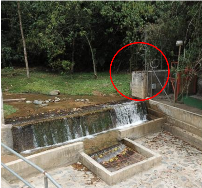
Imagen 13. Instalación mecánica Equipo de Medición (Propia)
