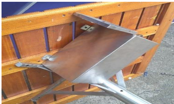
Figura 26. Instalación caja inferior.
