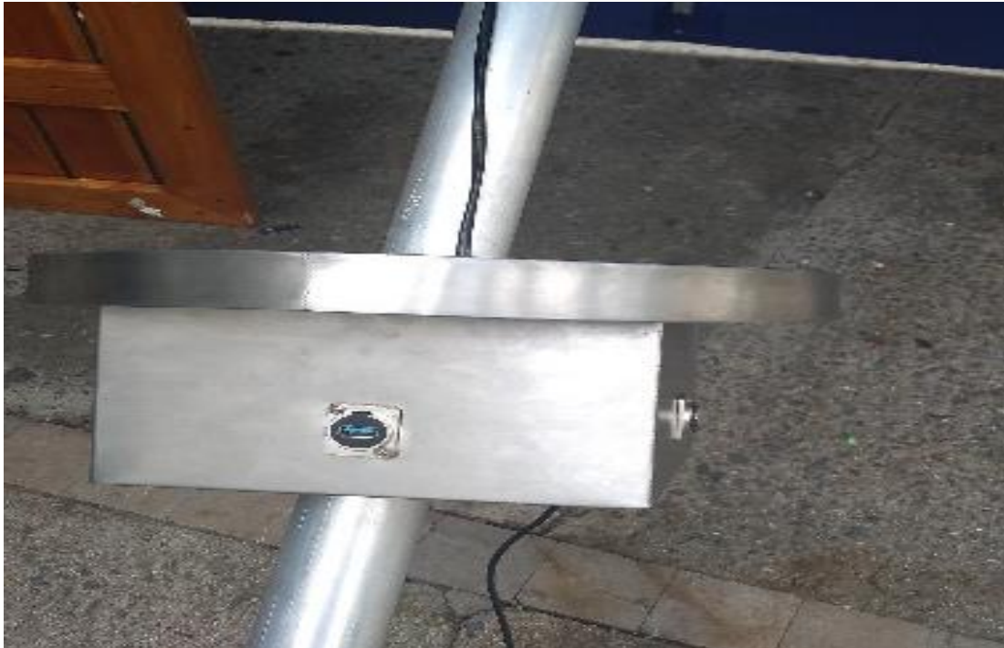
Figura 27. Instalación de base y caja para tomas USB.
