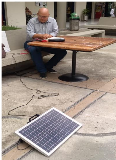
Figura 19. Toma de datos iniciales con el panel solar.
