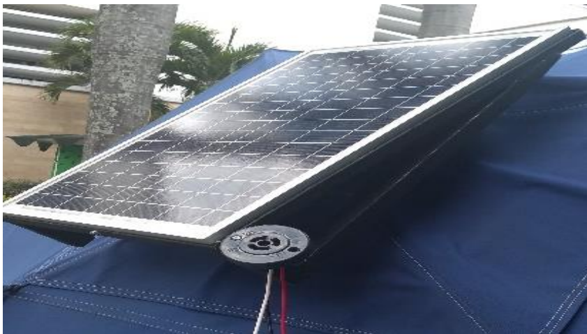
Figura 25. Instalación panel sobre la base
