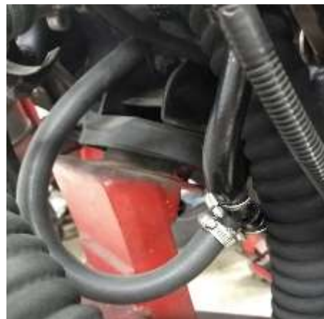
Figura 29. Adaptación de la manguera de descargue de aceite del turbo cargador al motor. Fuente: Autores.
