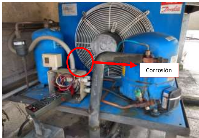
Imagen 28. Unidad condensadora
