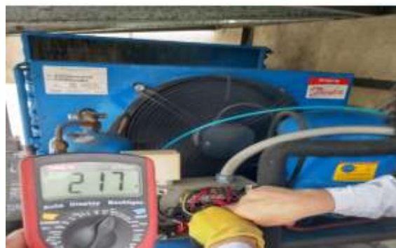
Imagen 34. Unidad condensadora
