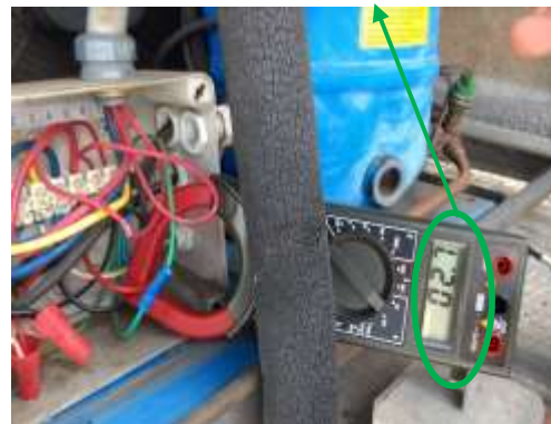
Imagen 36. Toma de medición de corriente
