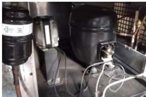
Imagen 56. Unidad condensadora
